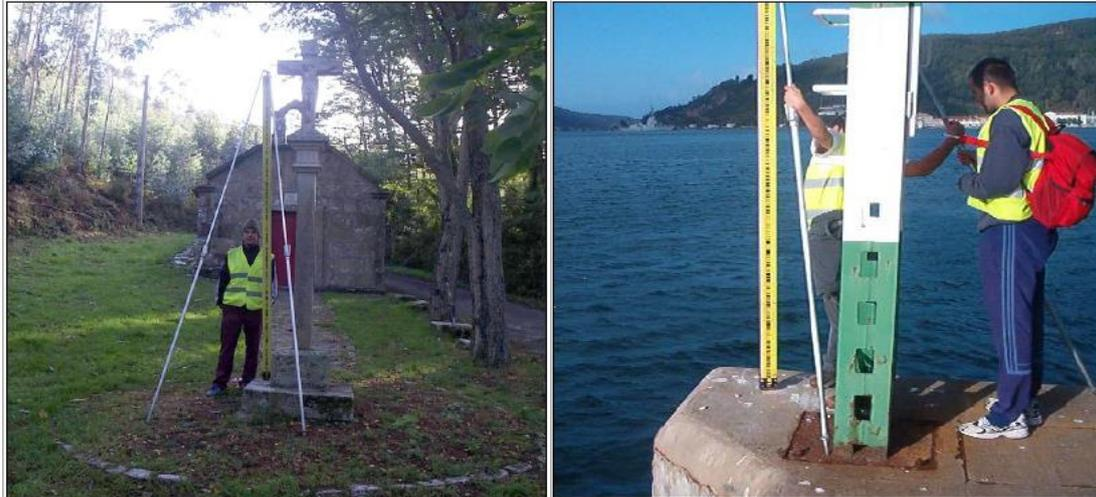
*Figura 2. Trabajos de nivelación del mareógrafo de Ferrol.*
