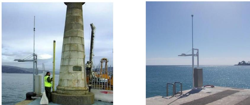
*Fig. 2. Mareógrafos REDMAR con estación meteorológica instalada*
